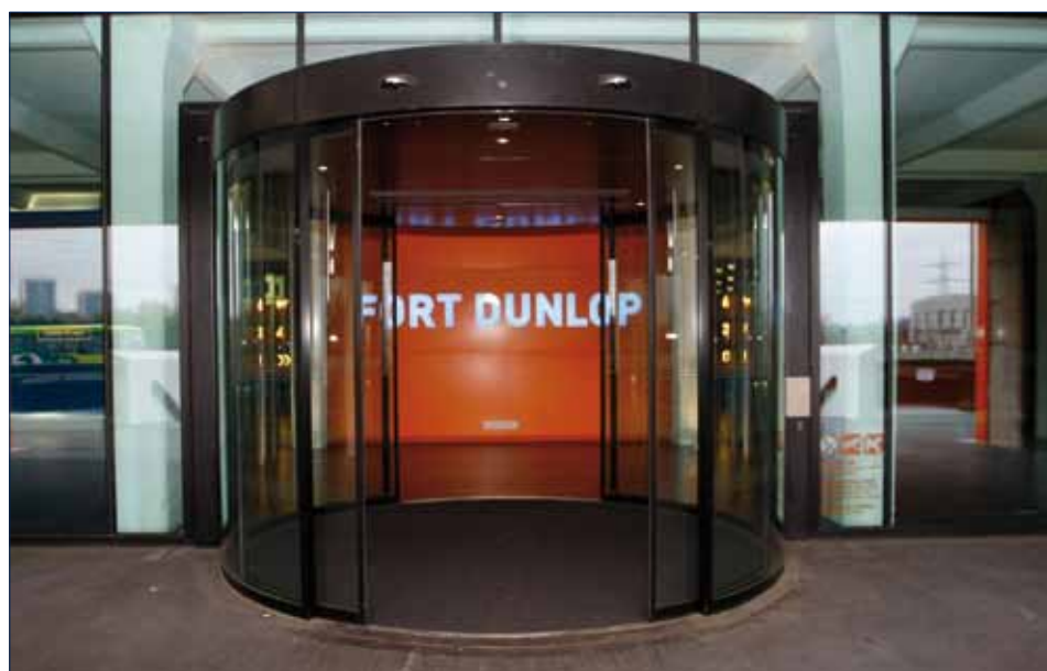
Fort Dunlop, Birmingham UK Porte coulissante plein-cintre GEZE Slimdrive SCR à installation de rideau d'air chaud intégré dans la couronne du plafond surélevée
