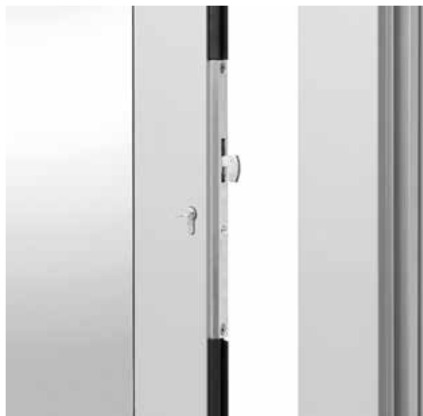
Serrure à crochet GEZE Lock M intégrée dans le vantail
