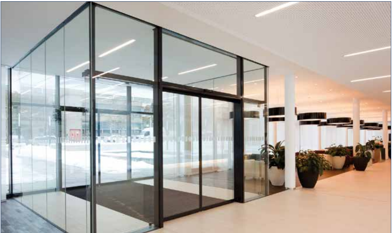
Slimdrive SL NT avec sas, Augustinum, Stuttgart, Allemagne (photo : Dirk Wilhelmy)
