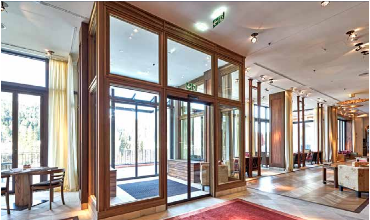
Slimdrive SL NT, Château-Hôtel Elmau Retreat, Elmau, Allemagne (photo : Robert Sprang)
